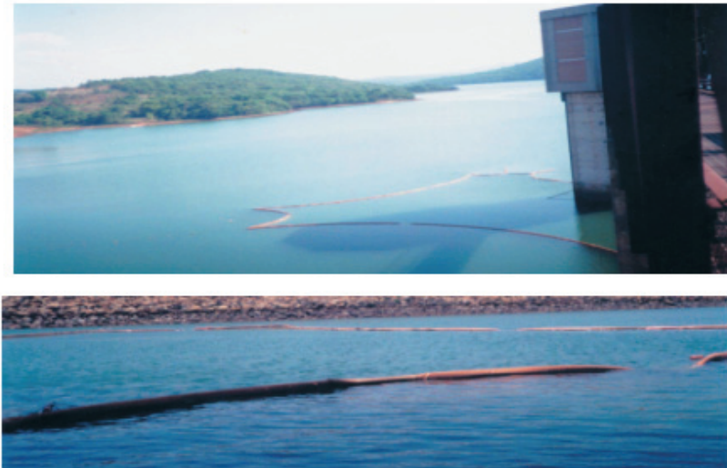
Figura 4.10 Estrutura da barreira flutuante construída pela COPASA mostrando os problemas de flutuabilidade.
