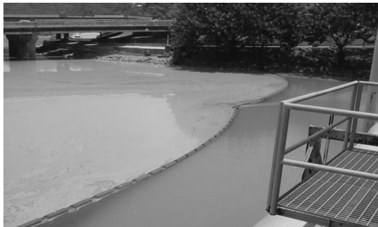
Figura 4.8 Utilização de barreira flutuante na contenção de floração no sistema Rio Grande/SP (RIVELINO et al , 2003).
